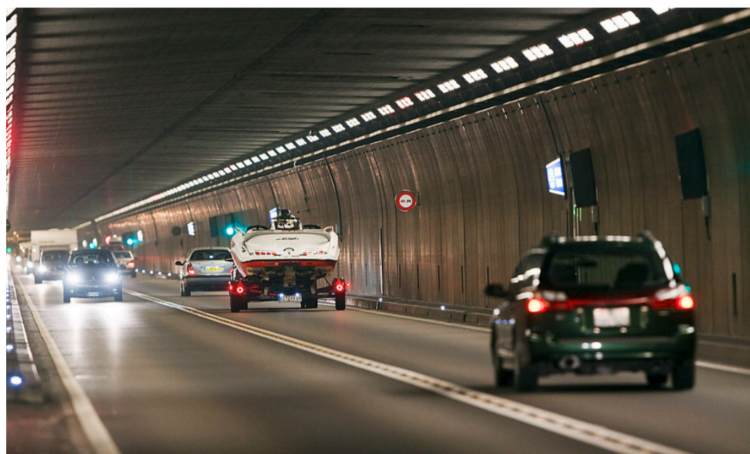
Muss in den nächsten Jahren saniert werden: Täglich passieren durchschnittlich rund 17 000 Fahrzeuge den Gotthard-Strassentunnel.
